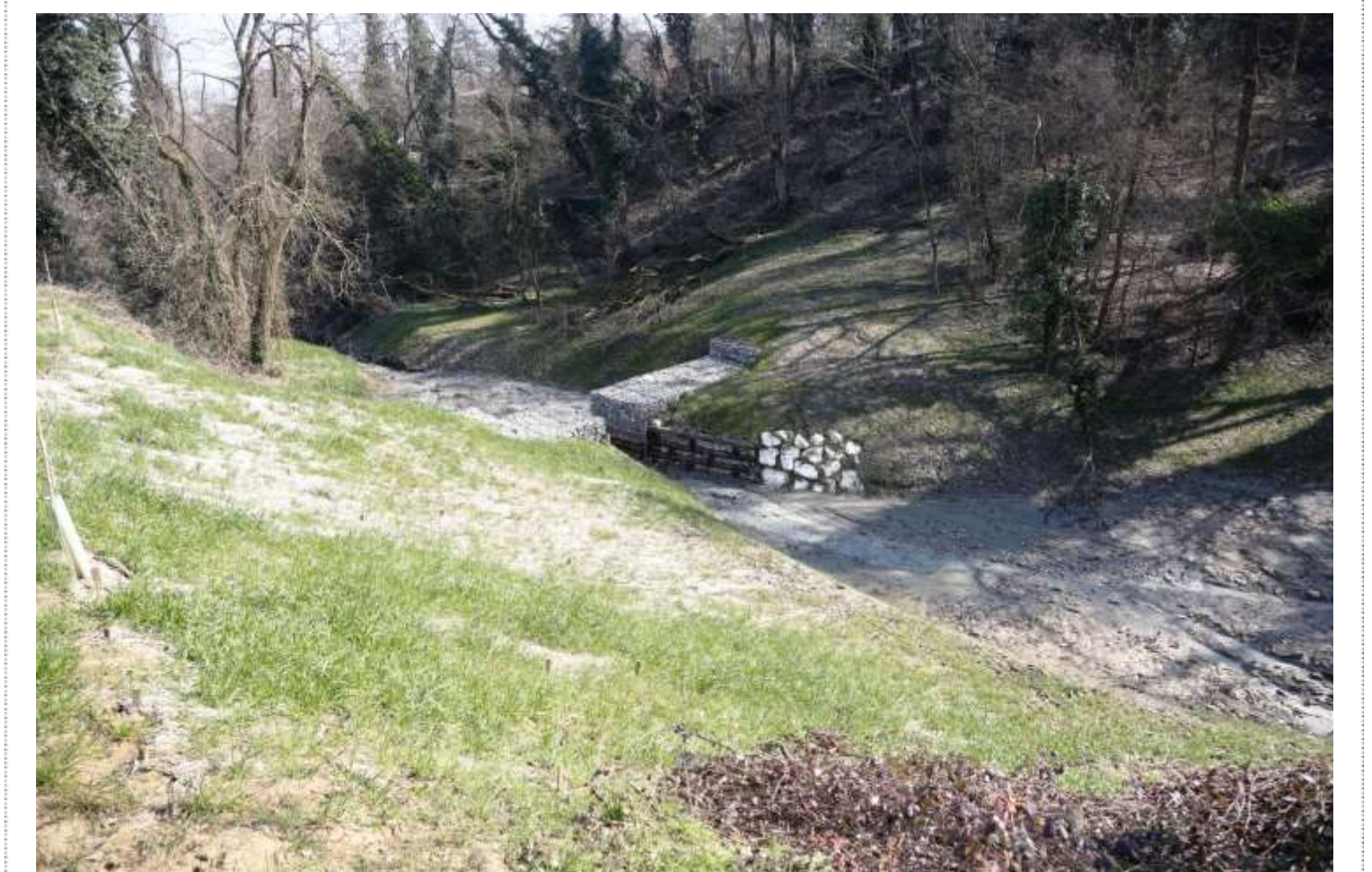
FOTO 3 – RESTRINGIMENTO IN PIETRE RINVERDITO LUNGO IL RIO BIANELLO A MONTE DELL'ABITATO DI QUATTRO CASTELLA (RE)
